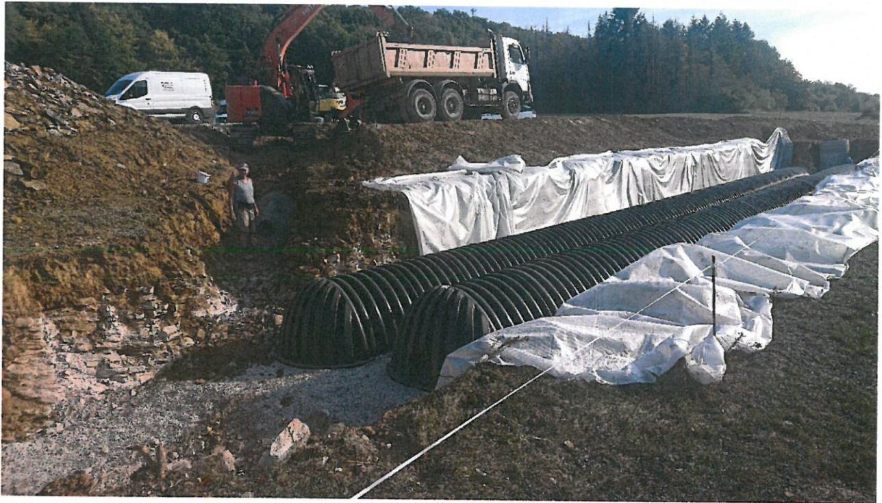
Mise en place des bassins de rétention de l'eau pluviale
