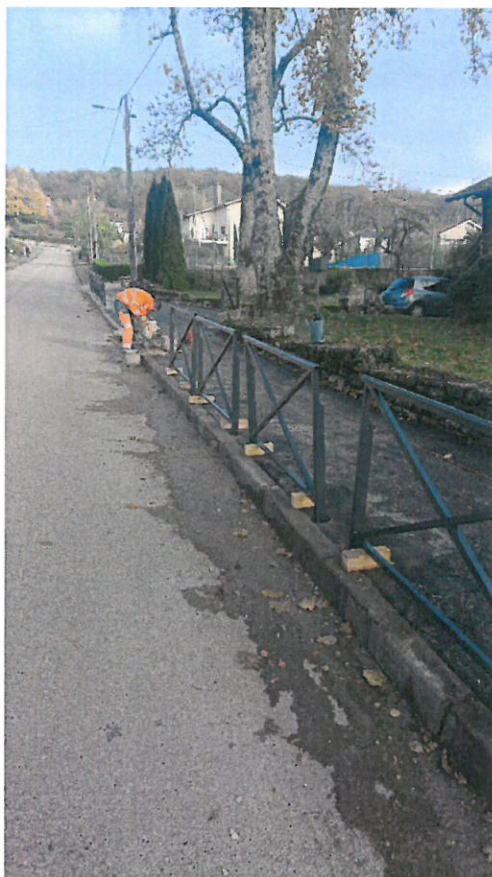
Pose de barrières de protection le long de l'école maternelle
